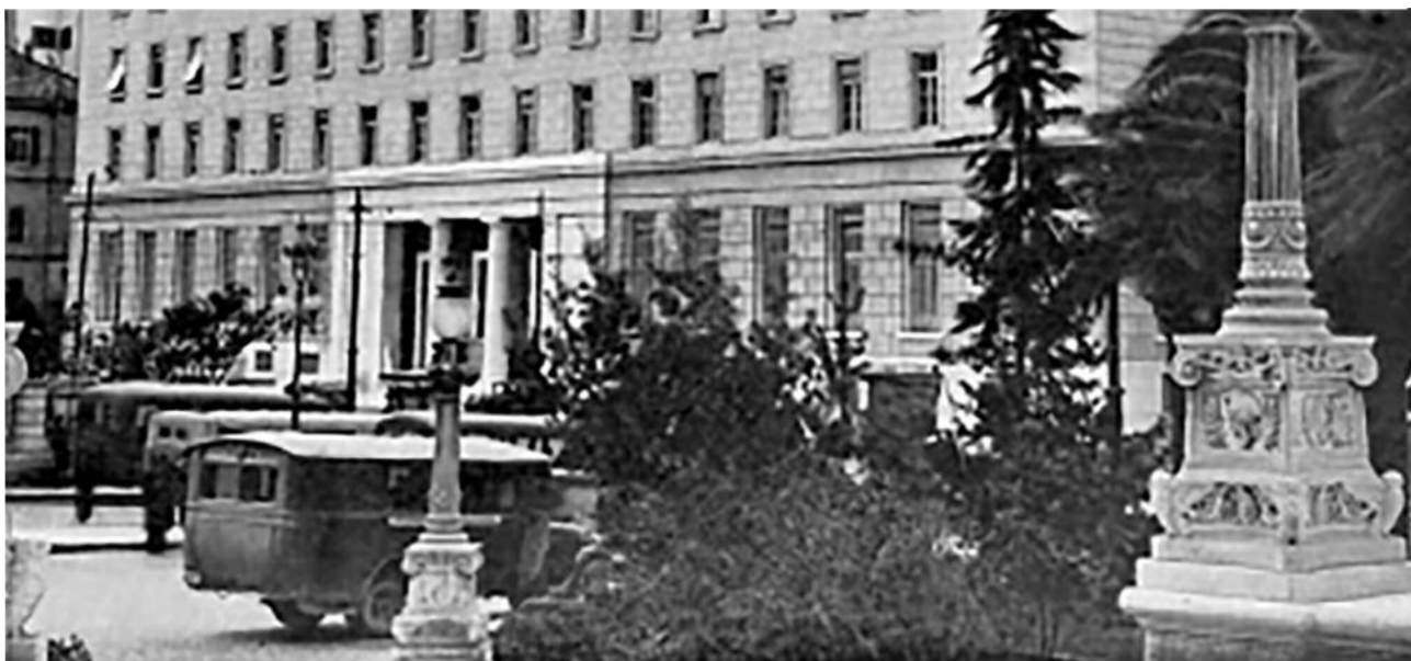
Κεντρικό Κατάστημα επί της οδού Ελ. Βενιζέλου 21, Αθήνα 1938
